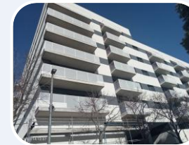
Edifici Barberá (Barcelona)
