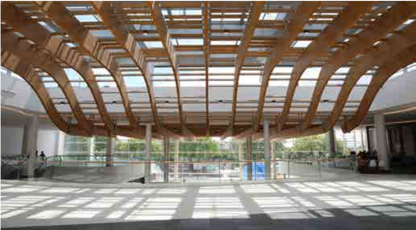
Imagen del centro comercial Ànec Blau (Barcelona) tras la finalización de una parte de los trabajos de reforma.
