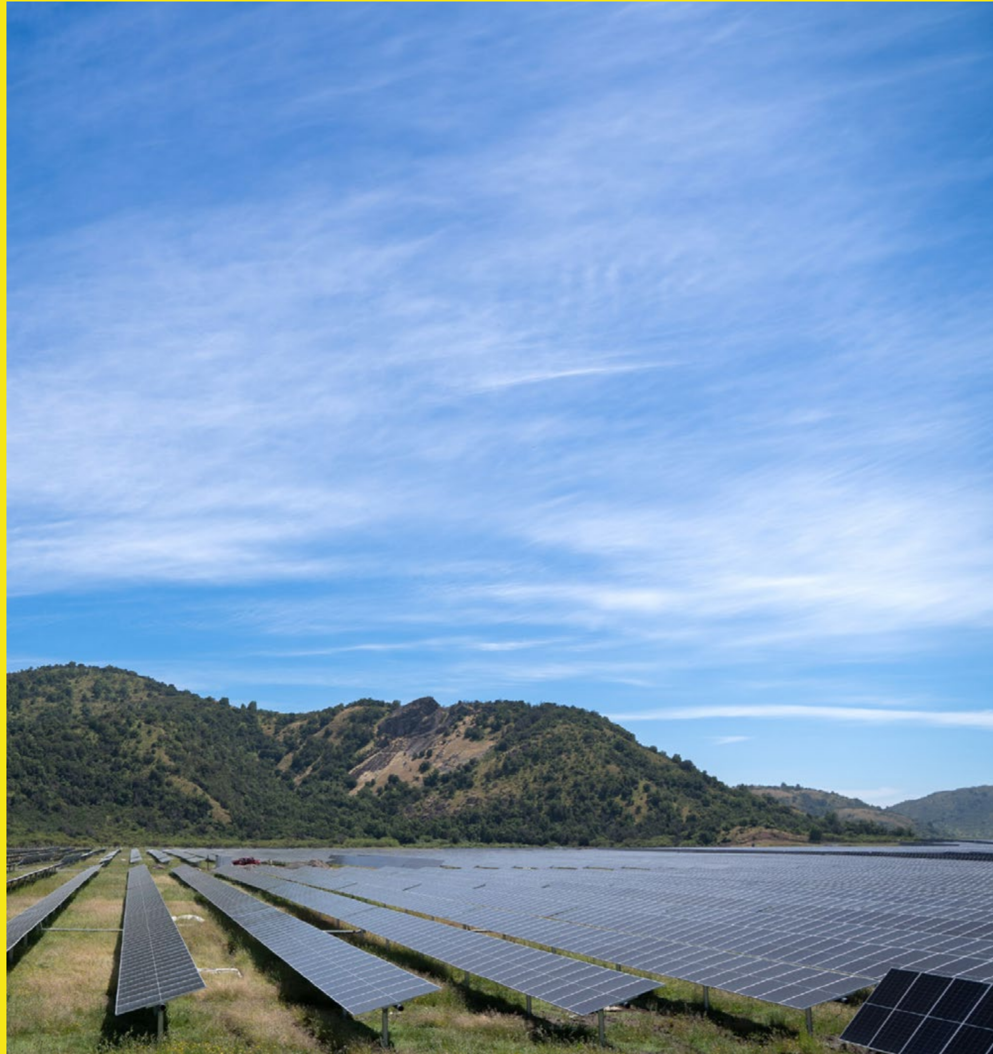
Gran Teno 200 MW PV plant, Chile
