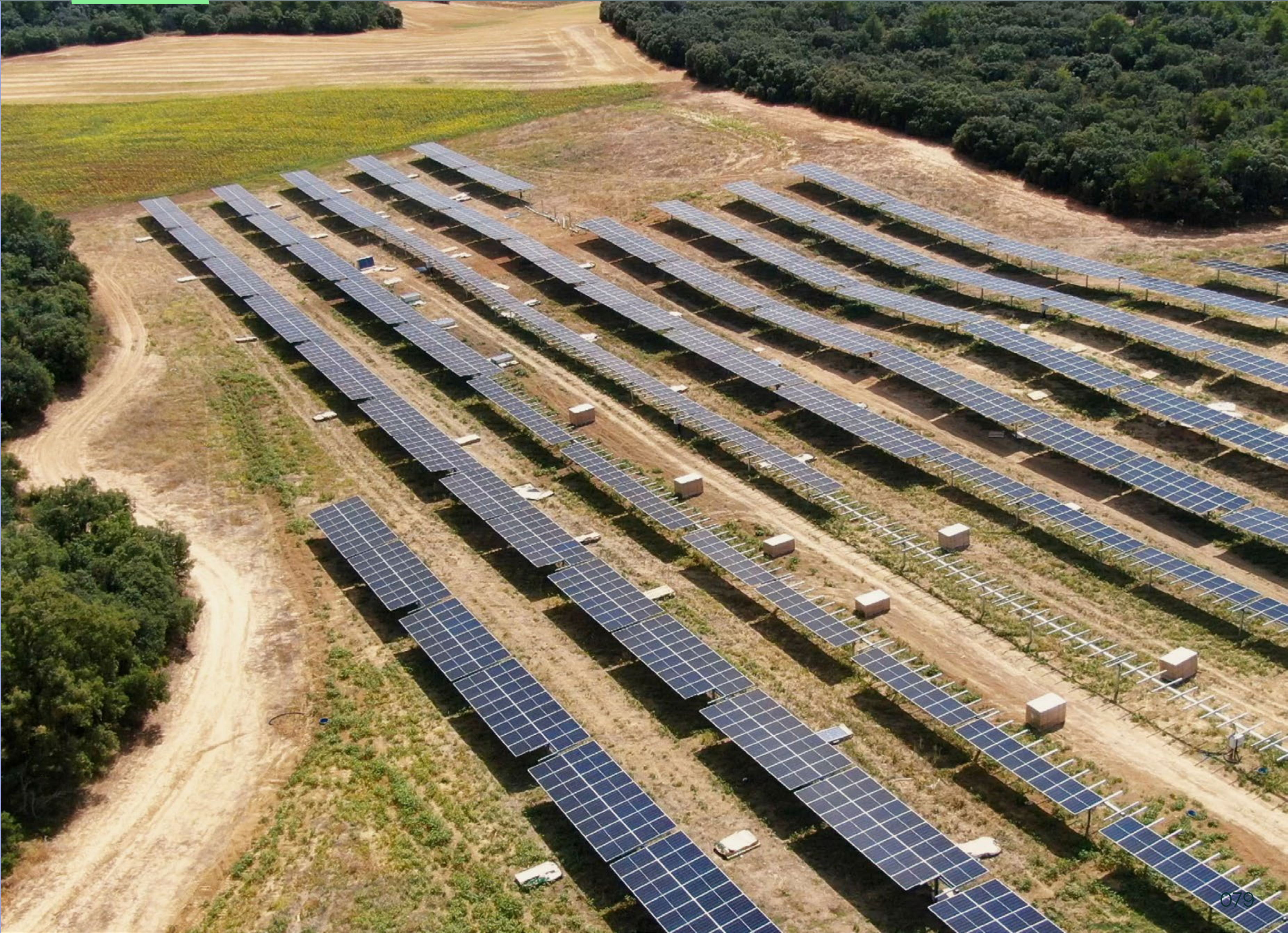
Construcción planta FV Escuderos 200 MW, España
