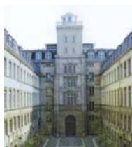
Rue Grenelle 22.000 m2
