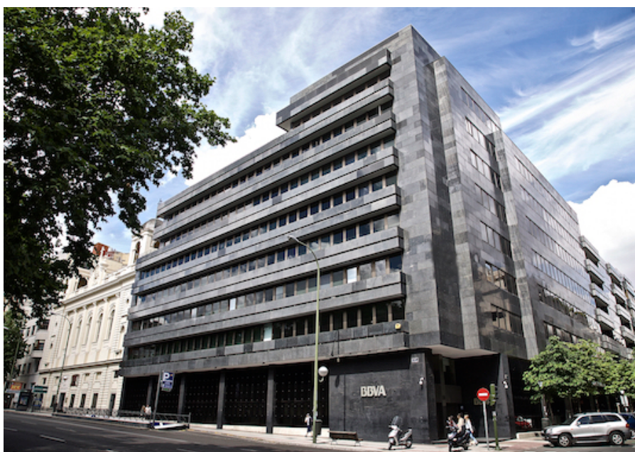
Foto: Axiare Patrimonio - Edificio Velázquez en el CBD de Madrid.
