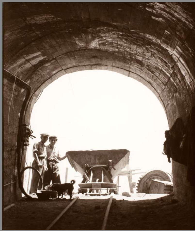
Túnel de Horna, Soria (1940)
