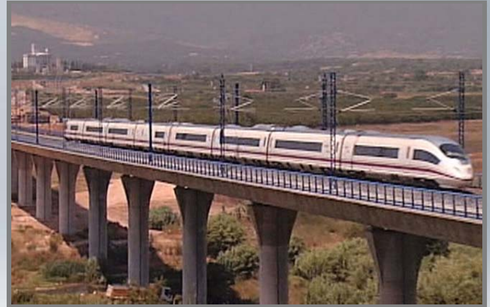
Puente alta velocidad, Madrid-Barcelona (2008)
