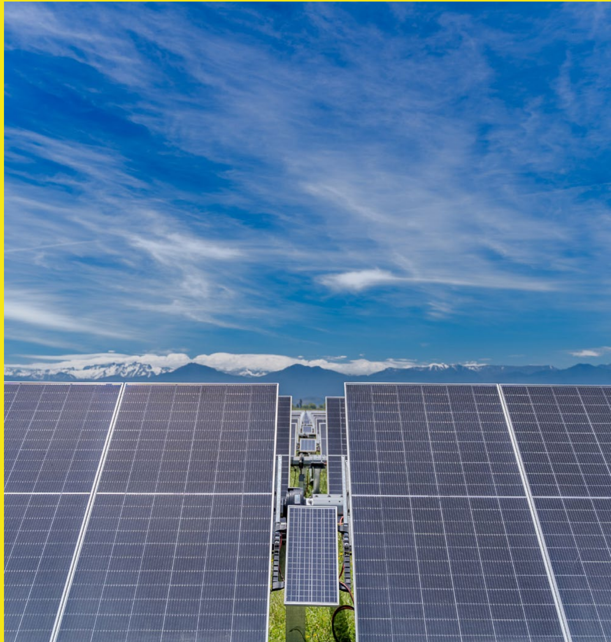
Gran Teno 200 MW PV plant, Chile
