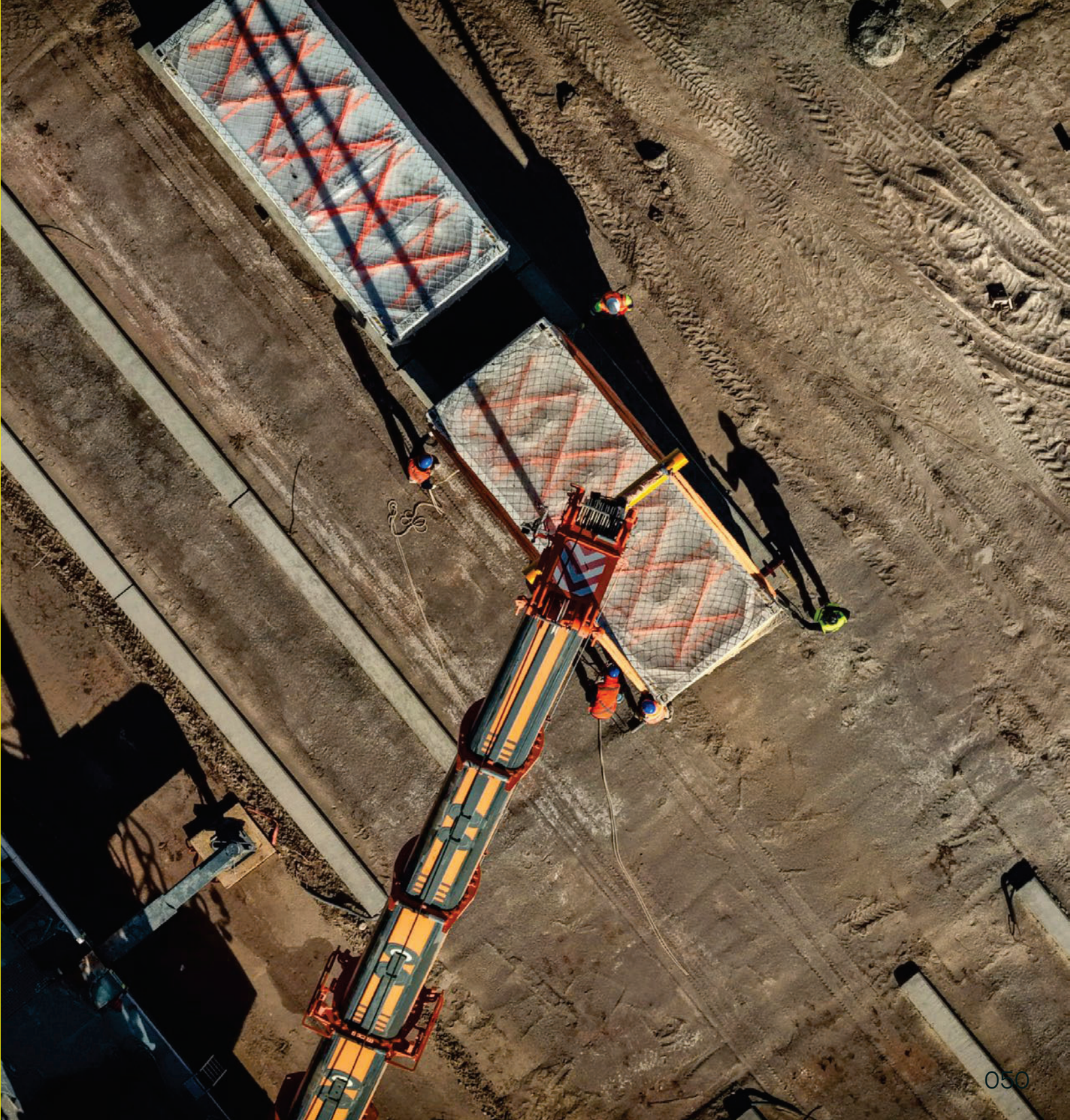
Montaje de baterías en planta híbrida Elena 446 MW + 3,5 GWh, Chile
