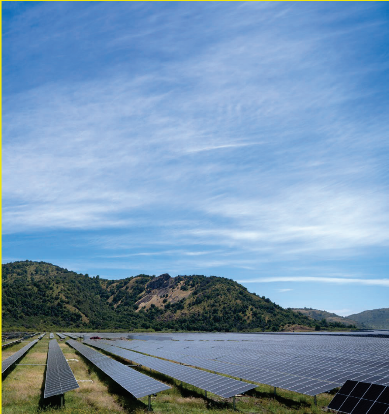
Planta FV Gran Teno 200 MW, Chile
