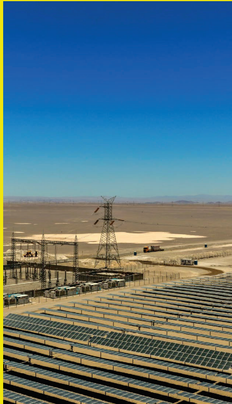
Instalación baterías del parque híbrido Elena 446 MW + 3,5 GWh, Chile
