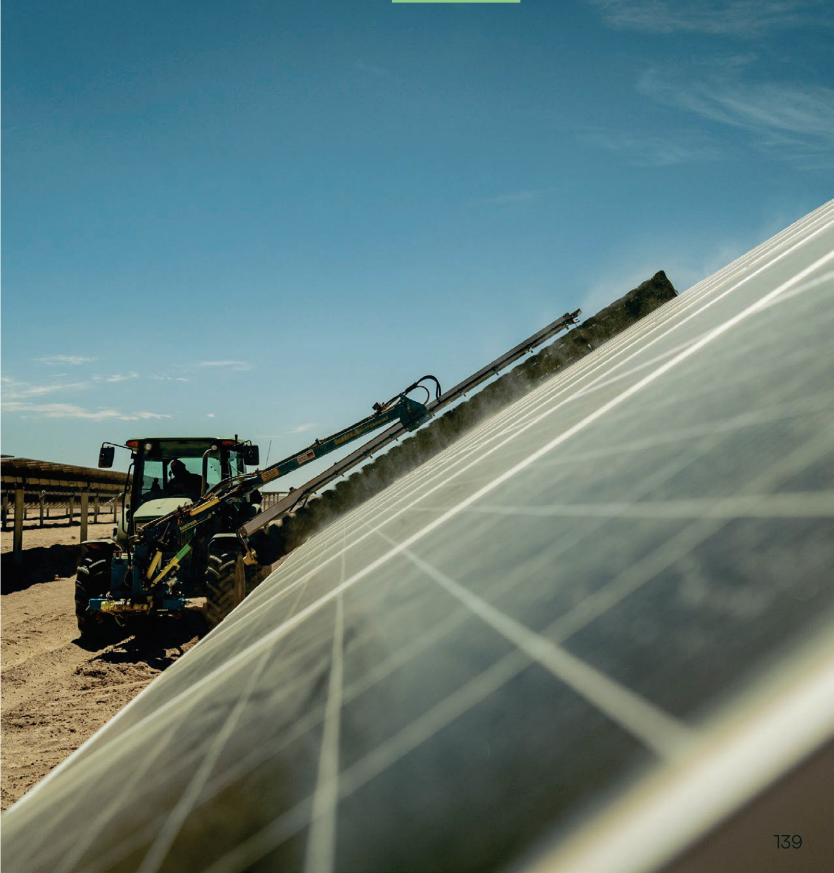
Limpieza de paneles solares planta FV Quillagua, Chile
