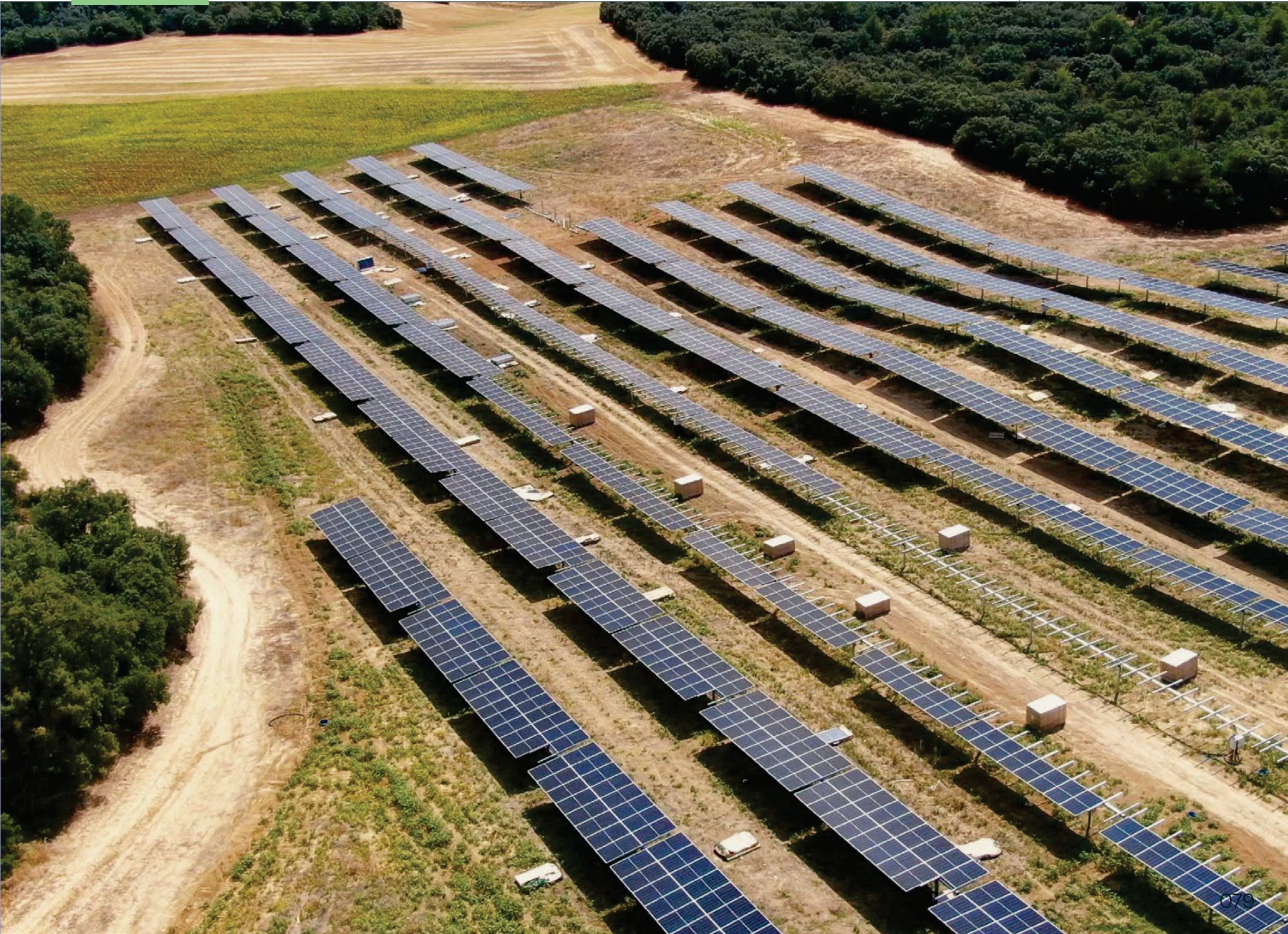
Construcción planta FV Escuderos 200 MW, España
