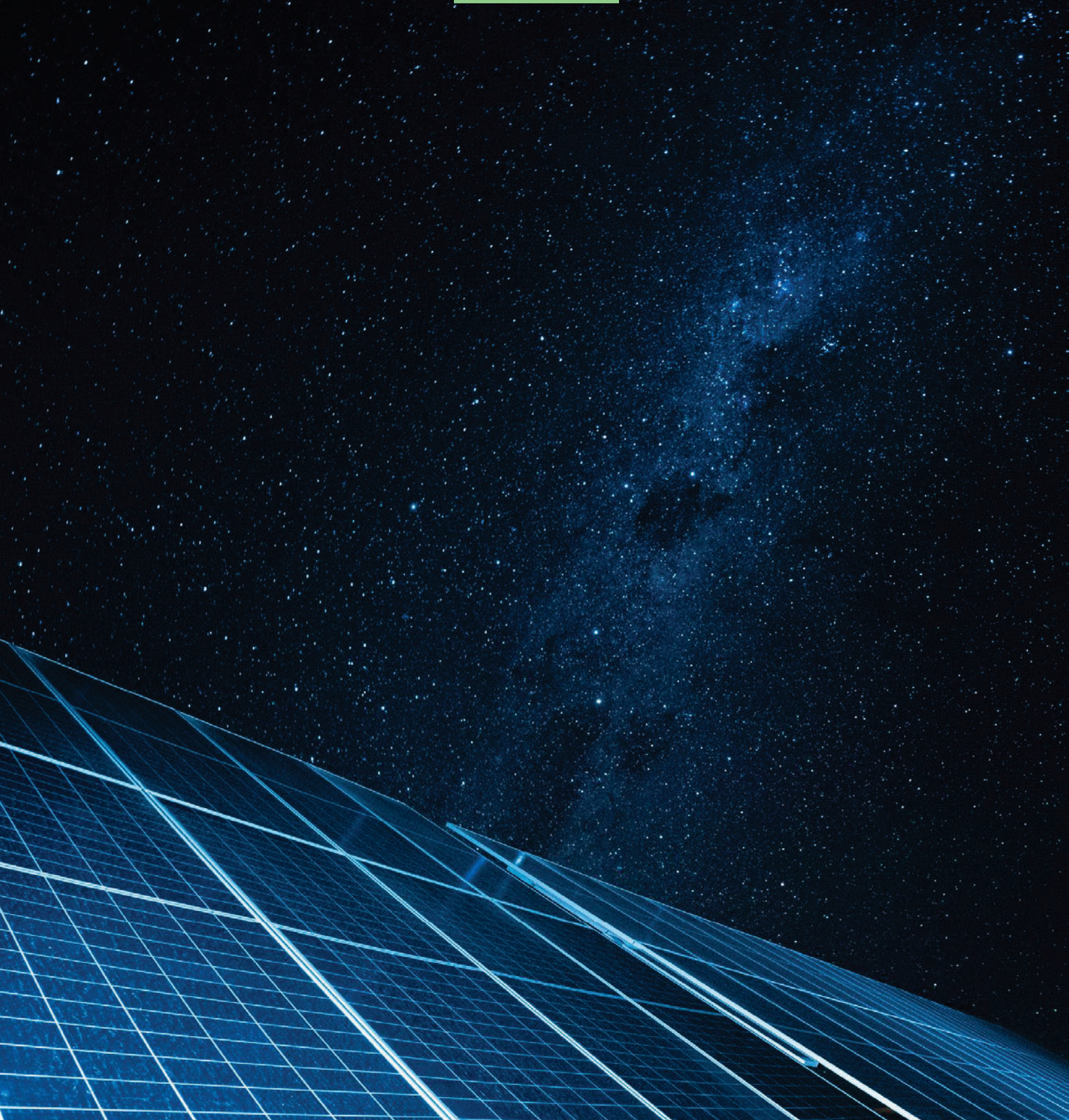
Planta FV Quillagua 103 MW, Chile
