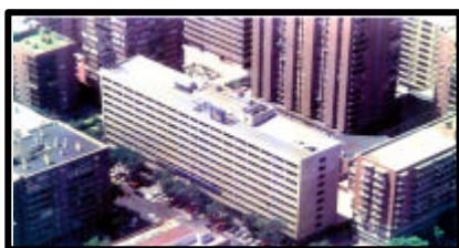
Edificio Capitán Haya 53 Situación Actual
