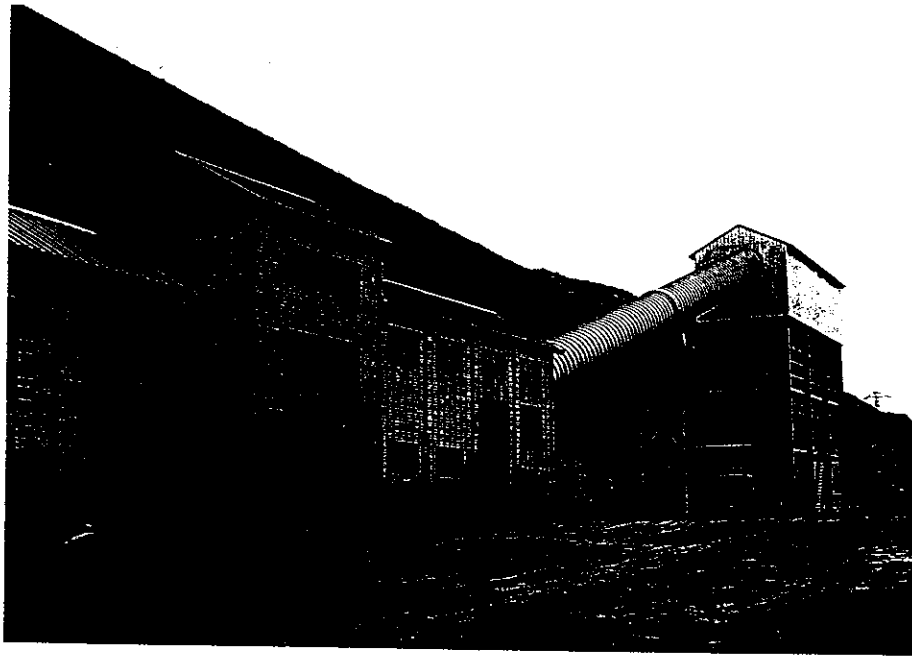
Instalaciones 4º Piso
